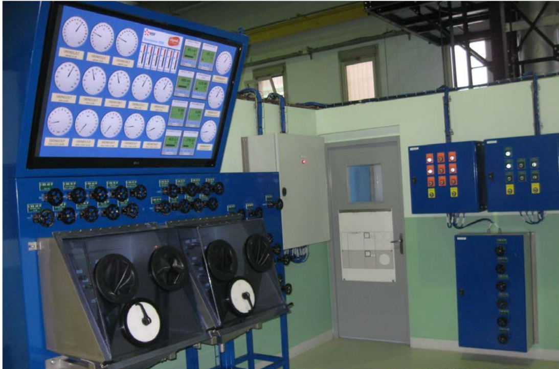
Le poste de formation simule en temps réel le circuit d'échantillonnage nucléaire.
